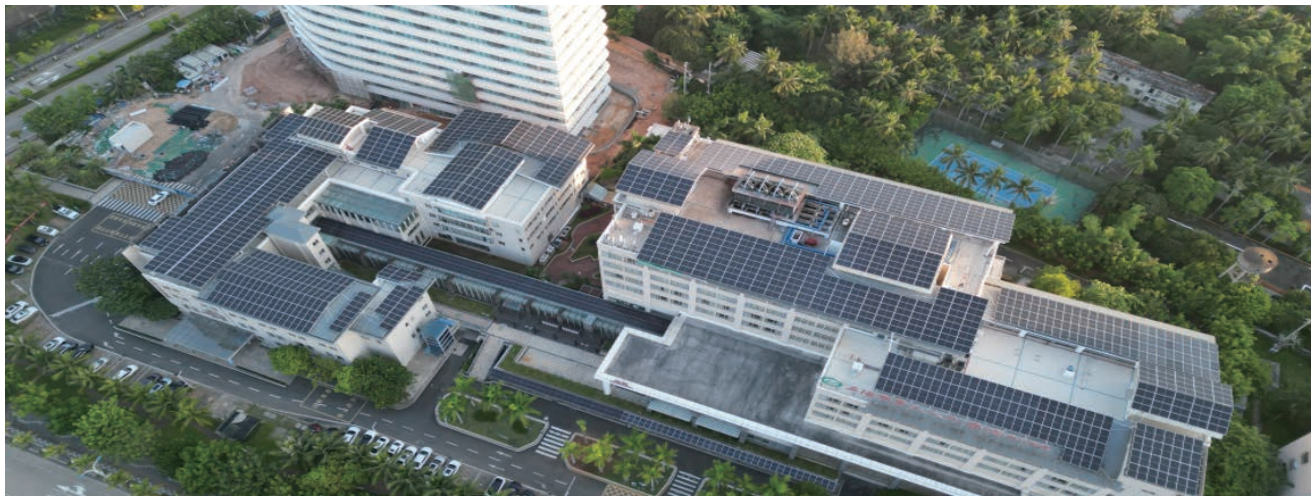
Hainan, Chine Date de l'installation : 2023
